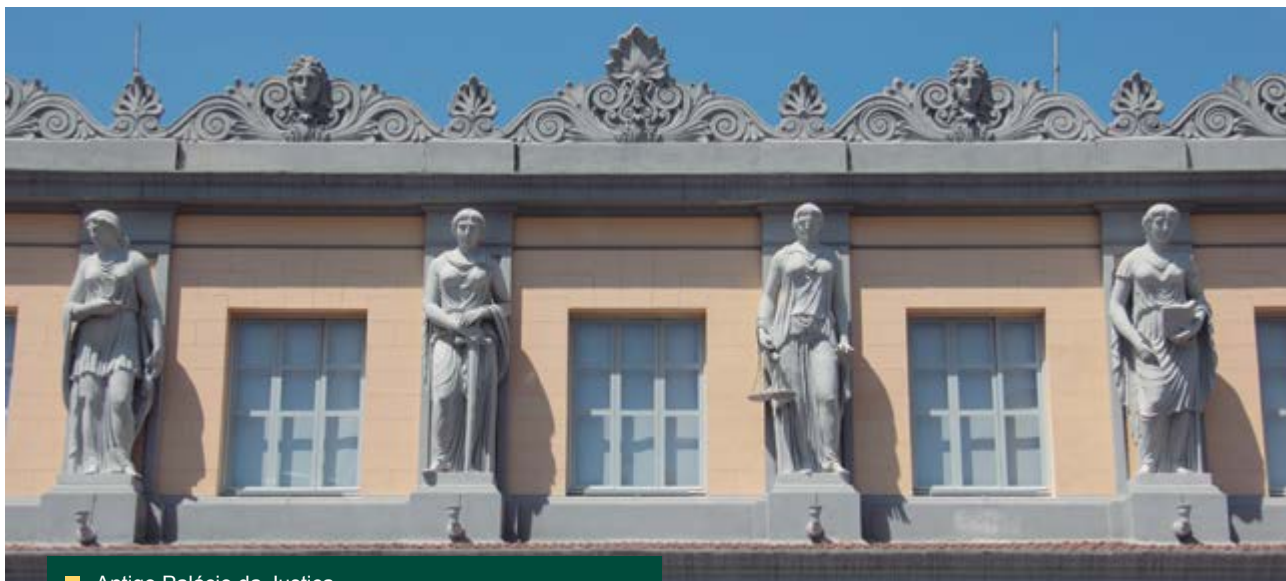
■ Antigo Palácio da Justiça, na Rua Dom Manuel nº 29 Centro – Rio de Janeiro - RJ – detalhe da fachada
